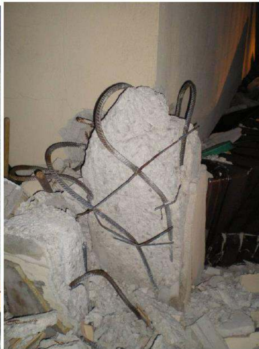
Particolare di uno dei pilastri collassati
